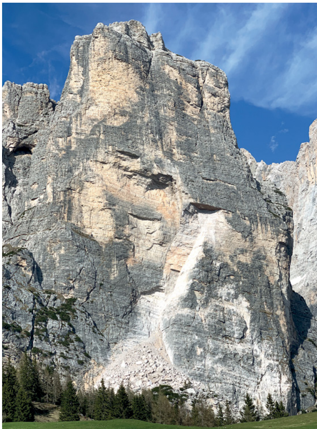
Frana sulla Torre Venezia (archivio Dell'Agnola - Karpos)
